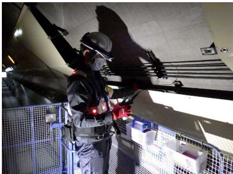
写真6－1 道路トンネルの点検状況
