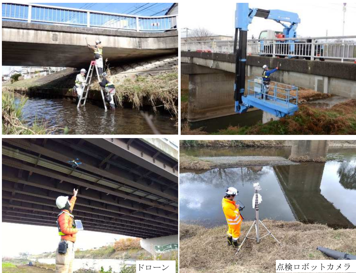
写真6-1 橋りょう点検状況
