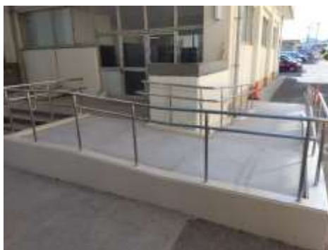
バリアフリー化 （外部スロープの設置）
