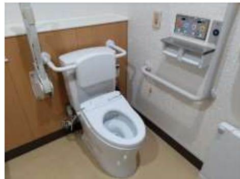
みんなのトイレ （手すり・温水洗浄便座）
