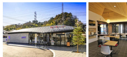
事例：バス停に整備された交流スペース併設コンビニエンスストア「野七里テラス」（横浜市栄区） 出典：横浜市資料
