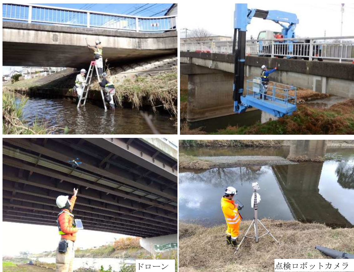
写真6-1 橋りょう点検状況
