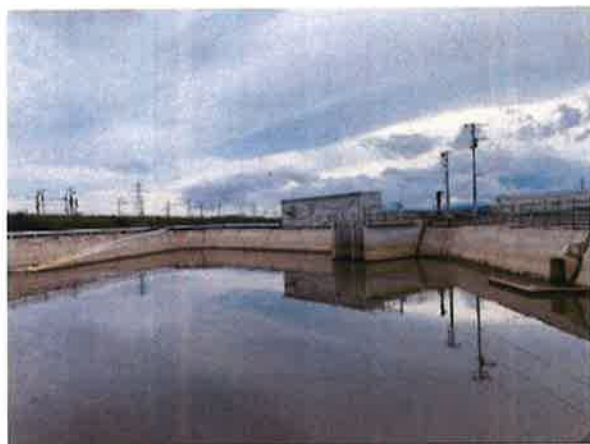
大神西調整池 (貯留量 約 10,000 m 3 )
