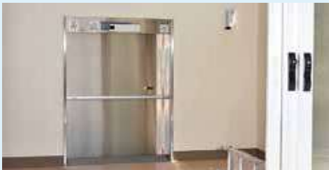
(上)「受入室」や「配膳室」などが増築された江陽中学校(浅間町8-1) (下)各階に配膳ワゴンなどを送る「小荷物専用昇降機」
