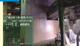
整備後 (補強壁)
