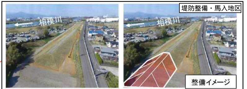
(出典) 国土交通省 関東地方整備局「相模川直轄河川改修事業」(一部加筆)
