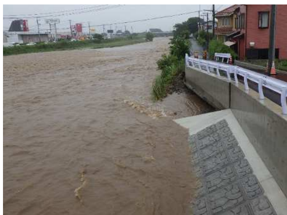
金目川の状況 令和3年7月（写真提供）神奈川県
