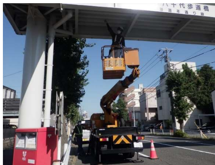
写真6—1 横断歩道橋の点検状況
