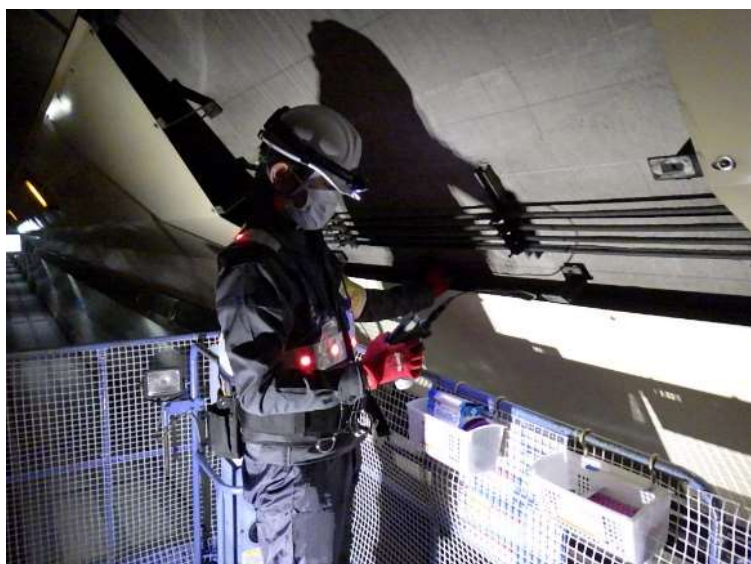
写真6—1 道路トンネルの点検状況
