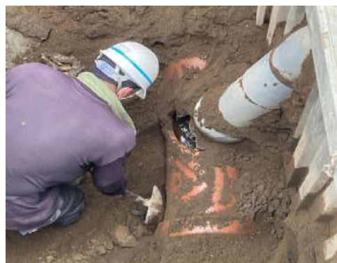
陶管の破損状況
