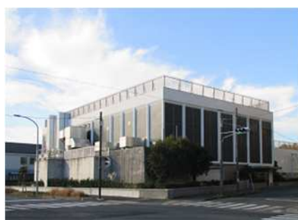
東部ポンプ場
