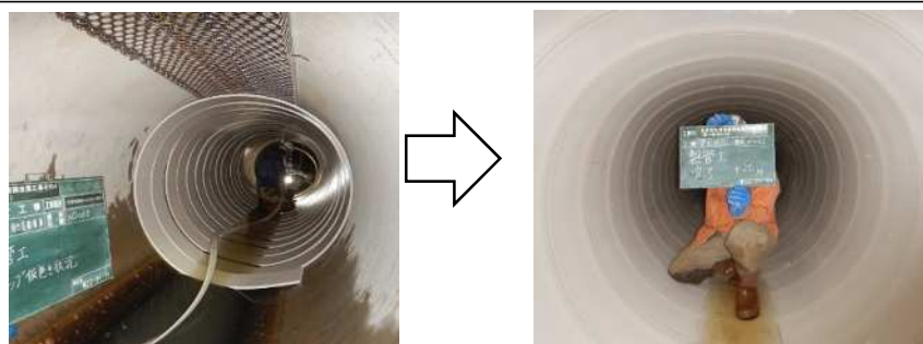
管路の長寿命化対策
