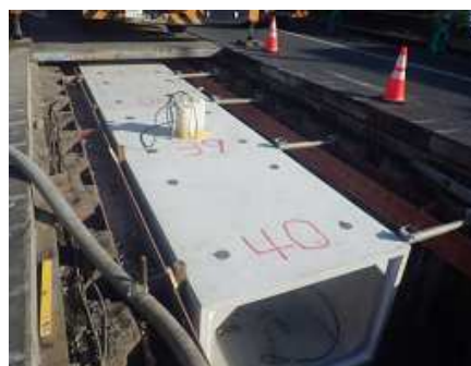
管路の入れ替え
