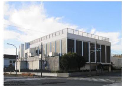
東部ポンプ場
