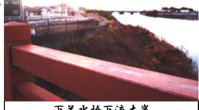
下花水橋下流左岸
