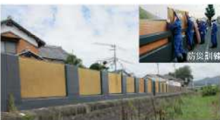
自主防災活動による置堤設置 (揖保川水系、たつの市)
