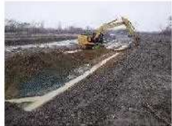
河道掘削 (石狩川水系、北海道開発局)
