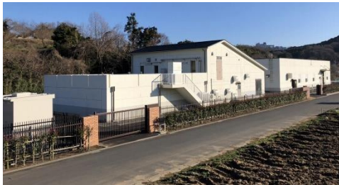
吉沢浄化センターと資源循環施設
