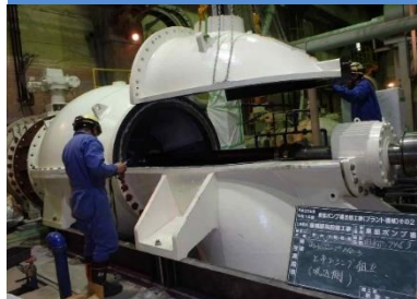
【改築更新】 東部ポンプ場改修工事
