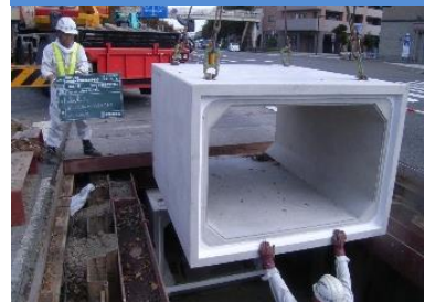
【改築更新】 国道1号における耐震化工事
