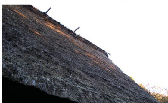
藁葺き屋根の 旧日本家屋
