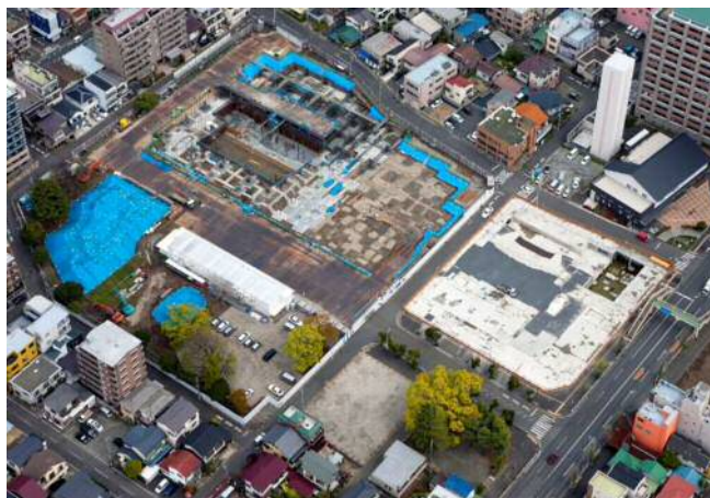
②文化芸術ホールのオーケストラピットの工事 旧市民センターの地下部分の解体
