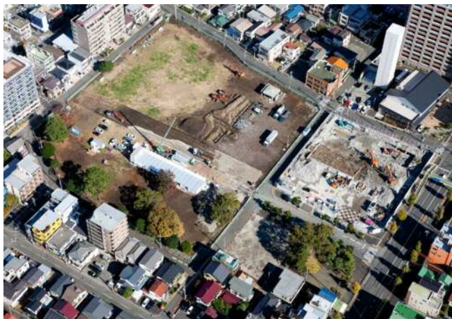
①準備工事段階 既存樹木を活かしながらか見附台公園の撤去
