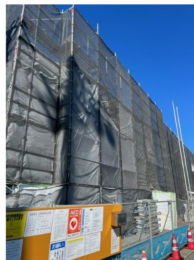
足場と飛散防止ネットに覆われている金目公民館
