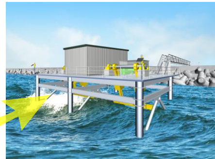
(新型波力発電装置/出力 100kW のコンセプト)
