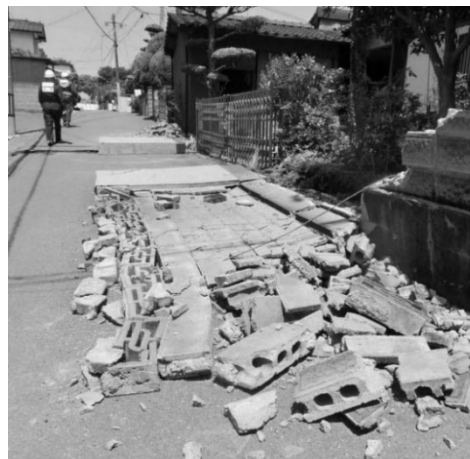
倒壊したブロック塀(出典:熊本地震デジタルアーカイブ)
