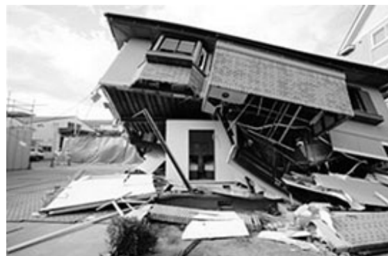
住宅の内部に設置された耐震シェルター
