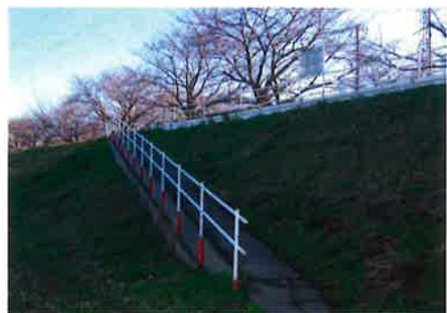
真土側のスロープ完成
