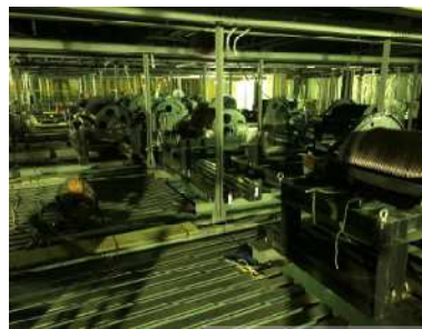
写真 舞台上部の 舞台機構装置
