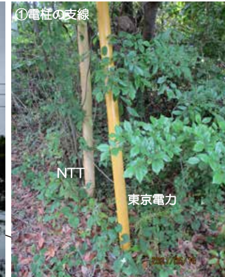
※聖苑敷地内の電柱①の支線2本（所有者：東京電力及びNTT）は、敷地内にある。支線の移設が必要な場合は、所有者と協議の上、移設すること。
