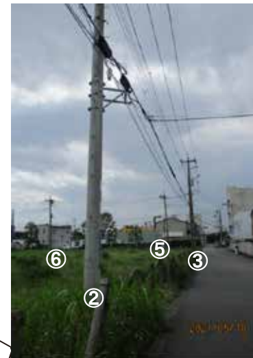
※聖苑敷地内の電柱①の支線2本（所有者：東京電力及びNTT）は、敷地内にある。支線の移設が必要な場合は、所有者と協議の上、移設すること。
