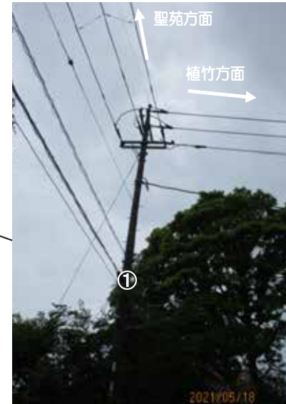
※聖苑敷地内の電柱①の支線2本（所有者：東京電力及びNTT）は、敷地内にある。支線の移設が必要な場合は、所有者と協議の上、移設すること。
