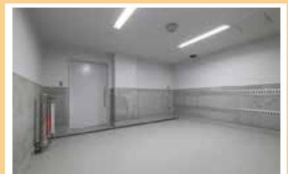
可搬動力ポンプ収納庫
