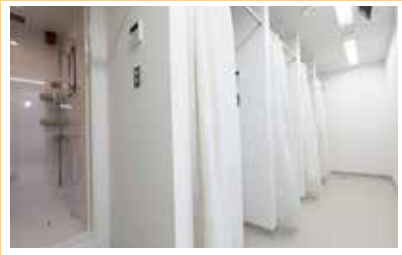
シャワー室・洗濯室・乾燥室
