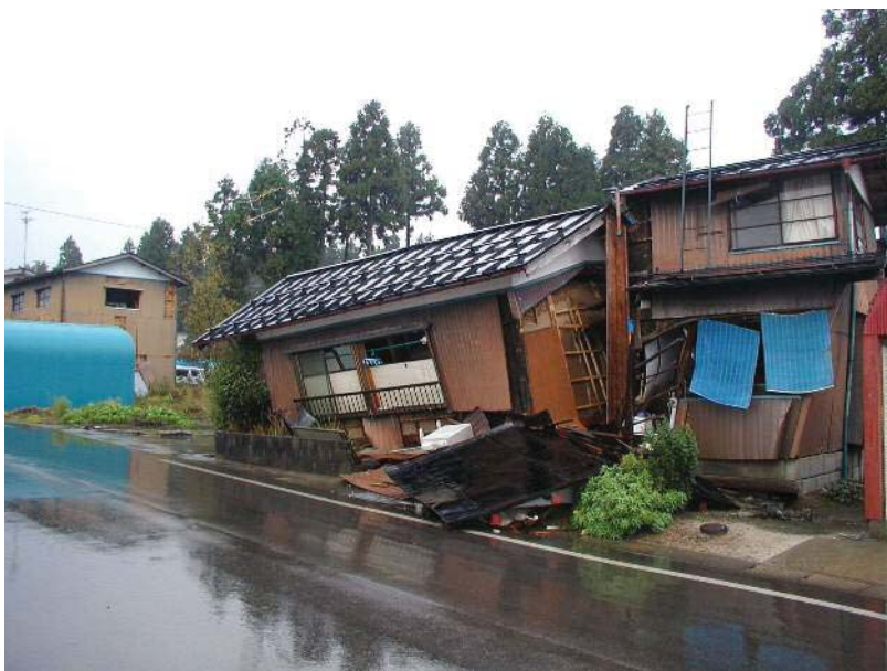
■地震により倒壊した木造家屋(平成 16 年 新潟県中越地震)
