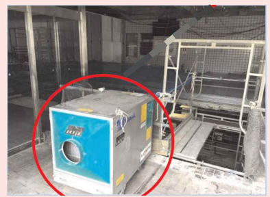
集塵機を設置し室内の換気を実施
