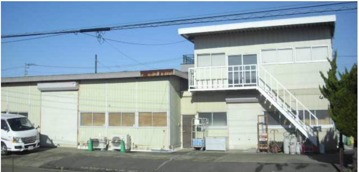
違反建築物の外観写真
