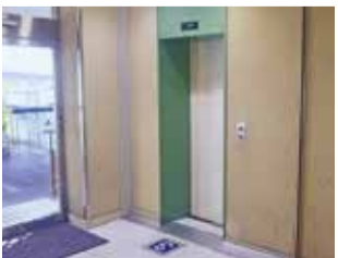
ラスカ西側エレベーターの様子
