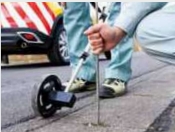
側溝の深さなども測定します
