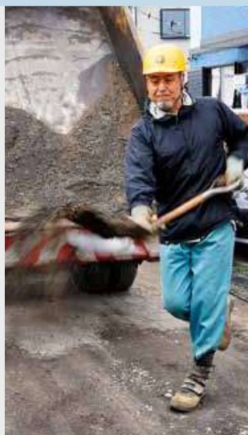
素早く正確に砂利をまき、固めます
