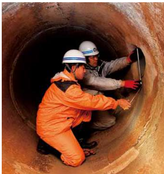
管の内部を見回り、管幅の測定などをします
