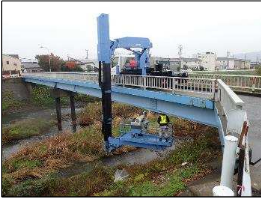
点検の状況（橋りょう）
