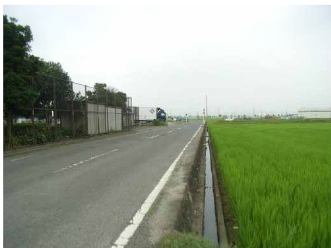
写真 5.2.11.1(1) No. A (西方向)
