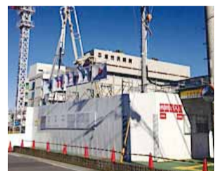
経営が破綻する中で建て替えが進む市民病院
