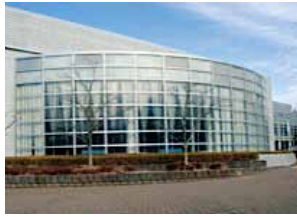
溺死事故が起きた平塚総合体育館プール
