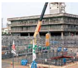
建設が進む市役所新庁舎
