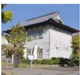
見附台地区再開発地域内にある現崇善公民館
