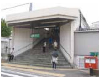
エレベーターが設置される平塚駅西口の南側出入口
