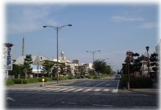
電柱・電線を地中化し、すっきりとした印象を与える通り
