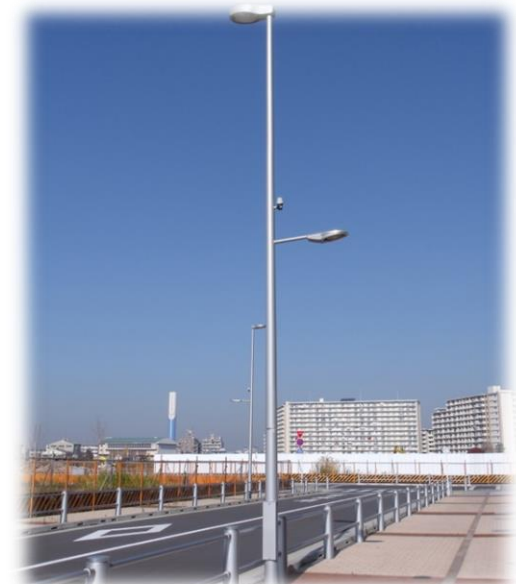
車道用と歩道用照明を一体化し、洗練されたデザインを採用した照明
