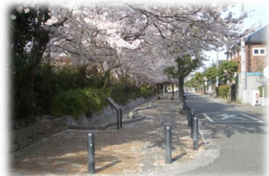
コミュニティ道路と水路を設置し、親しみやすさとゆとりある歩行空間を創出
