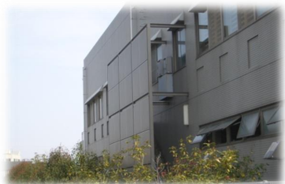
室外機の目隠し。建築物全体のデザインとの調和にも配慮されている。
