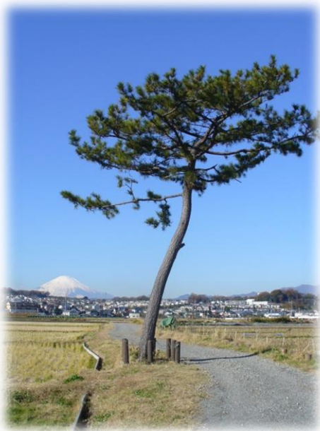
既存樹木を保存するため線形を曲げた農道整備
