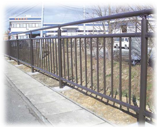
素材、色彩等を工夫し周囲の街路樹や歩道の仕上げになじむよう配慮された防護柵
