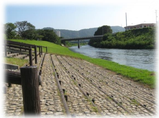
河原の石をイメージする舗装材を使用するなど、周囲の自然環境に配慮した親水施設
