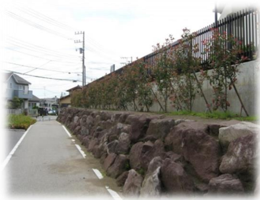
前面に植栽を施し、コンクリート部分を目立たなく配慮した擁壁
