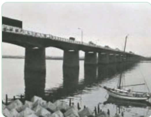
初代・湘南大橋
